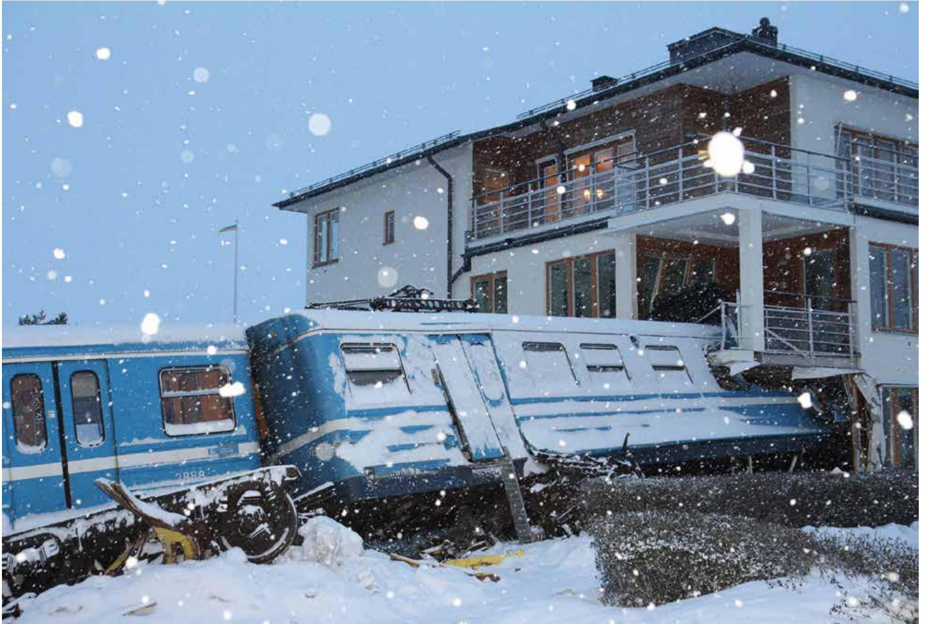
Vid tretiden på natten den 15 januari 2013 for ett av Saltsjöbanans tågset iväg mot ändhållplatsen i Saltsjöbaden, obemannat förutom en tågstäderska som av misstag kommit åt ett reglage. Hon blev svårt skadad men överlevde den våldsamma kraschen när tåget rände rakt igenom en stoppbock och in i ett bostadshus 25 meter bort. Foto: Marie-Louise Gravestam
