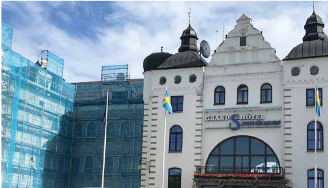
Den knottriga putsen byts ut och får en ny slät yta. Den ”klassiska” neonskylten ska få en ny utformning. Foto: Marie-Louise Gravestam
