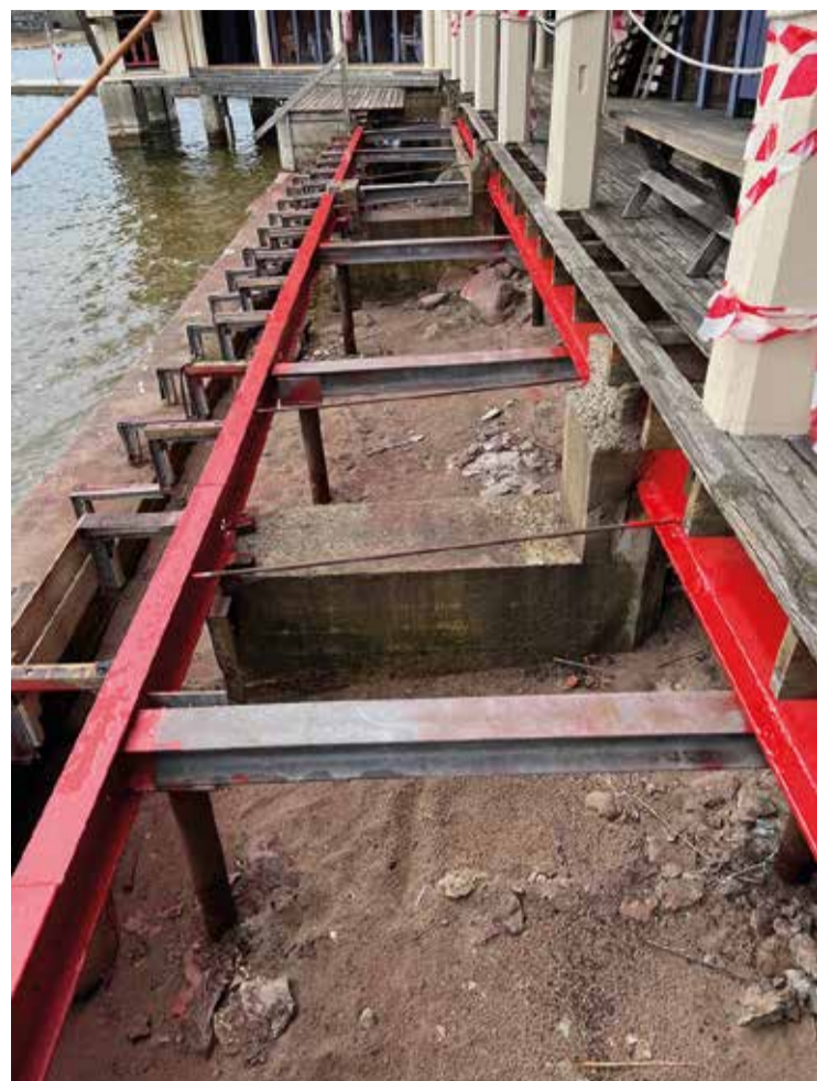
Trögångarna i herrbadet renoveras och ska få nytt plank.
