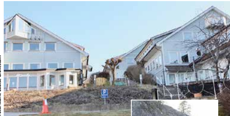
Huset byggdes på klassisk båtbyggarmark. Nu kan kontorslokalerna bli bostäder.
