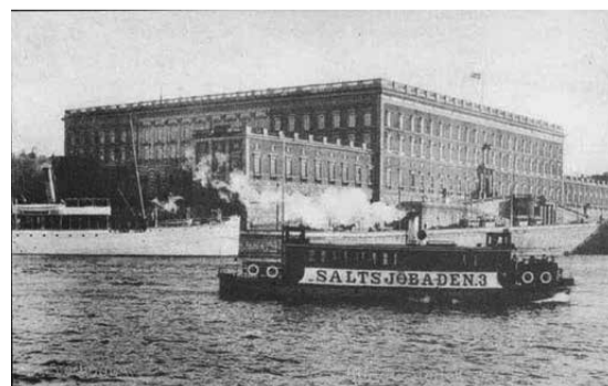
5. Färjor pendlade mellan Stadsgården, där Saltsjöbanan hade sluthållplats fram till 1936, och Karl XII torg.
