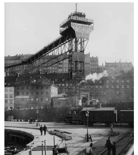
6. 1936 invigdes den nya Katarinahissen. Detta skedd i samband med att Saltsjöbanans slutstation hade fått sin nya slutgiltiga plats.
