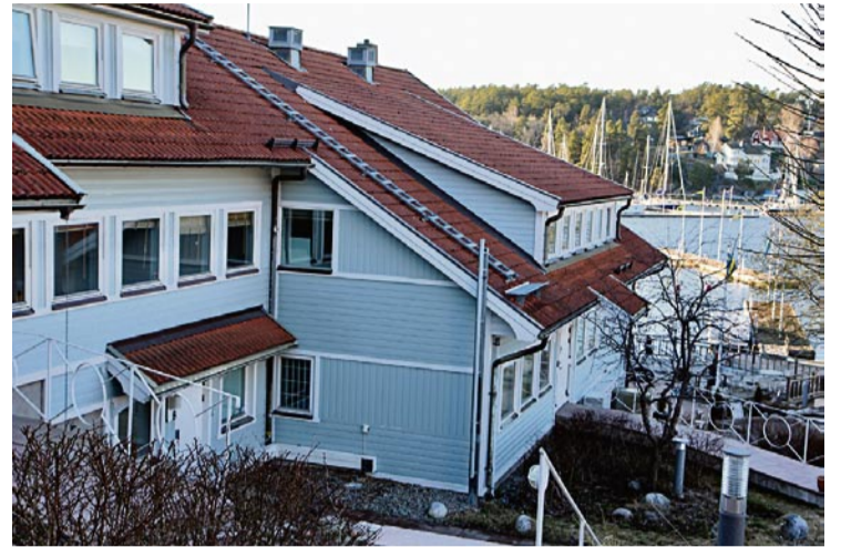
Den nu föreslagna detaljplanen för Neglinge Center/Vikingavägen 17 innebär att fastighetsägaren kan välja om de befintliga byggnaderna, med ett undantag, ska användas för bostäder eller kontorsändamål. Foto Marie-Louise Gravestam
